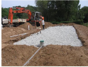
Mise en place d'un dispositif d'assainissement individuel
