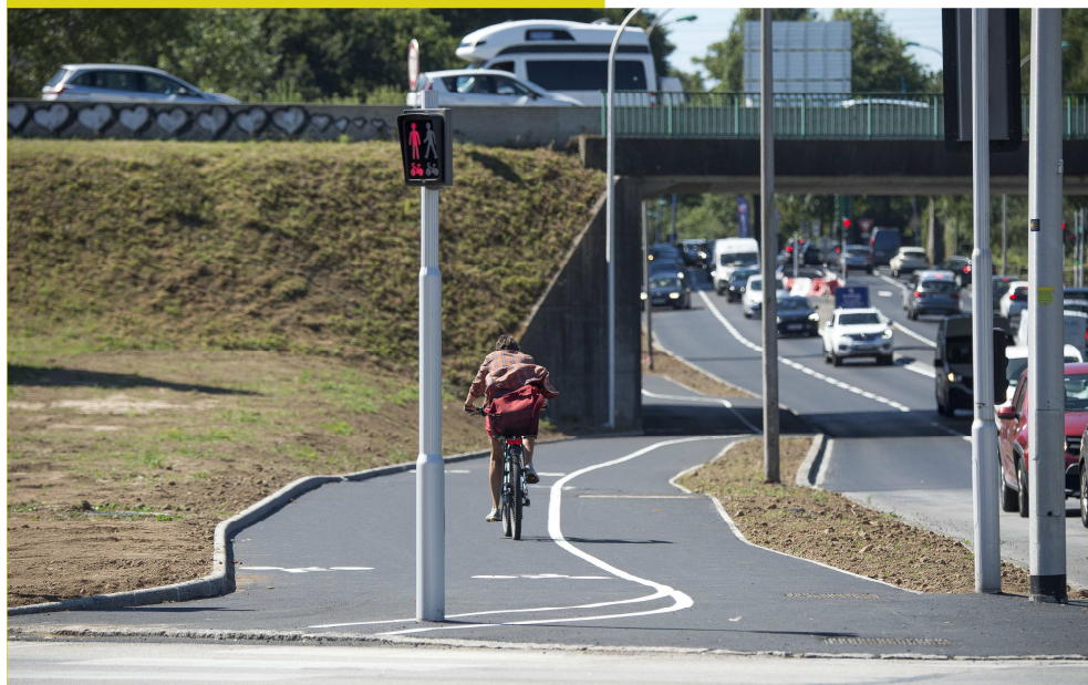
Nouvelle voie cyclistes/piétons boulevard de Pontivy
