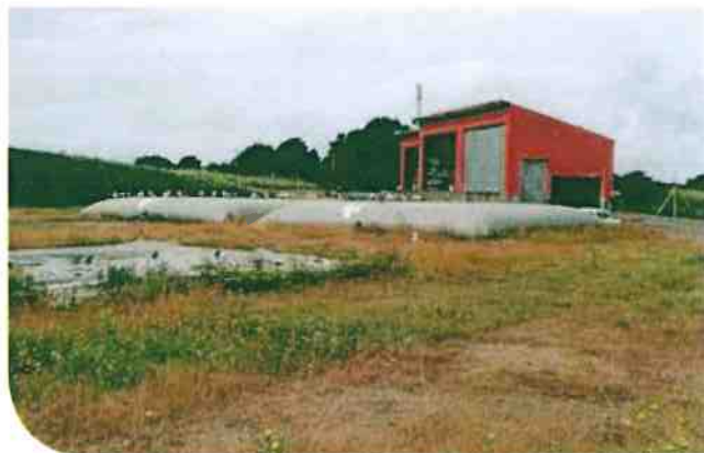
Ecosite de La Lande du Matz - Bâches de captage des lixiviats avant traitement
