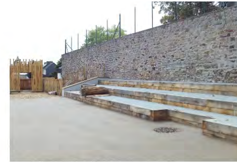
Accès PMR au gradins
