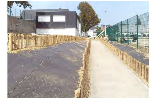
Rampe PMR d'accès à la cour
