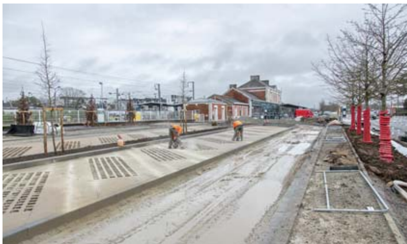
Le parking P1 a été entièrement réaménagé durant les mois de janvier et février.
