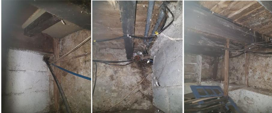
Réseau électrique d'allure anarchique en sous-face du plancher haut de sous-sol, câble électrique sectionné (fil dénudé). Raccordements bricolés de cette maison vers les deux autres du fond de parcelle.
