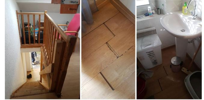
Échelle d'accès à la mezzanine très raide et non-conforme, garde-corps branlant, dangereux et non-conforme (risque de chute). Sol stratifié mal posé, lames qui glissent (risque de chute)
