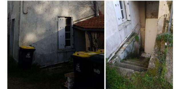
Absence de garde-corps au droit de l'escalier extérieur de descente au sous-sol, entraînant un risque de chute
