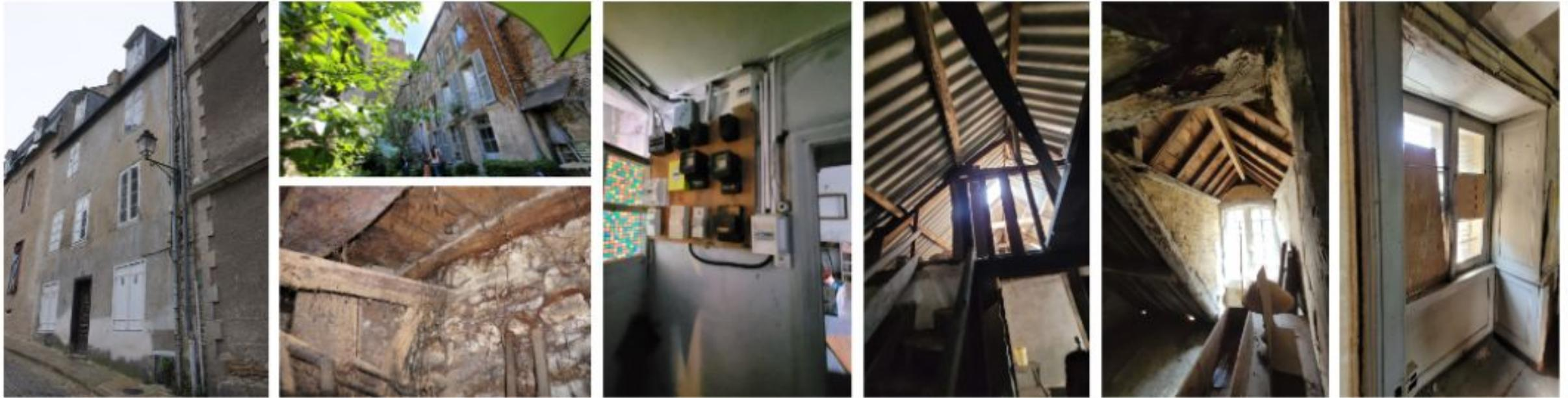
Murs à pans de bois en mauvais état sur le bâtiment avant, murs en pierres dégradés à l'arrière. Charpente et solivage des planchers bois en mauvais état.
