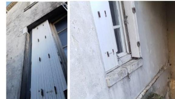
Les menuiseries vues depuis l'extérieur ne sont pas entretenues (peinture qui cloque, volets rouillés, bois dégradé), pouvant entraîner des défauts d'étanchéité à l'eau et à l'air.
