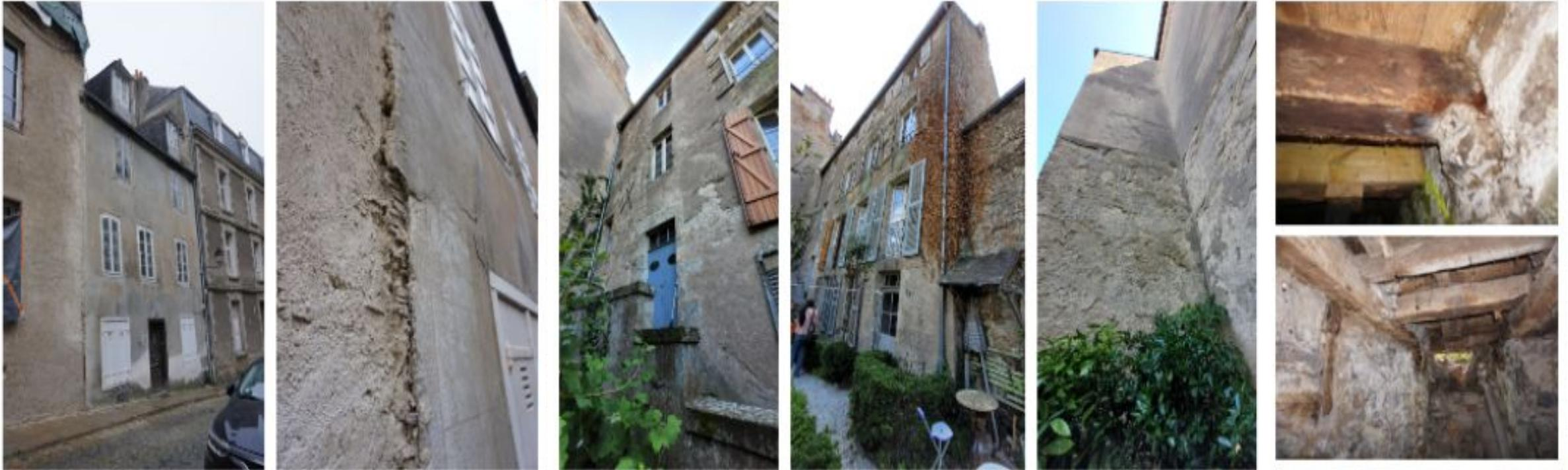
Murs à pans de bois en mauvais état sur le bâtiment avant, murs en pierres dégradés à l'arrière.
