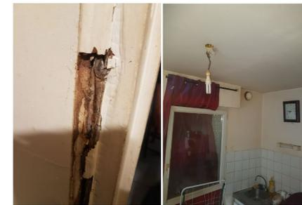
Bois de la porte de salle de bain ruiné par l'humidité. Douille électrique et câbles à nu (pas de boîtier sécurisé)
