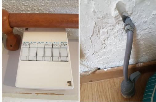
Défauts électriques multiples avec absence de conformité (absence protection à l'eau, différentiel, ...)
