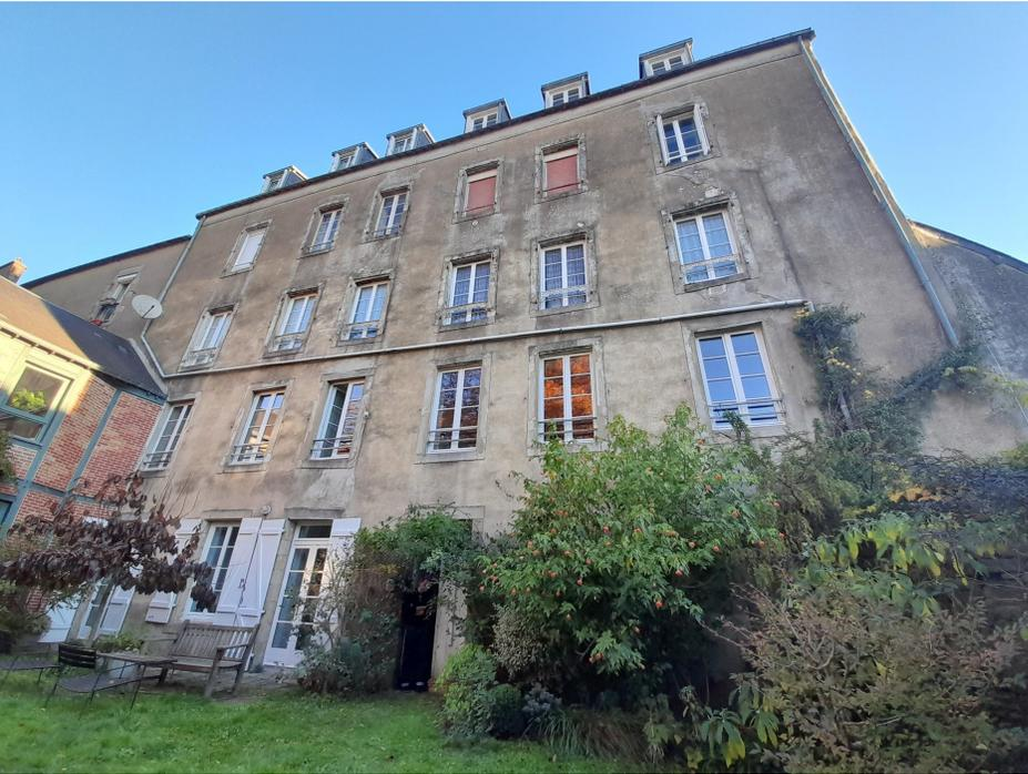
Façade sur jardin : stabilisation des fondations en rez-de-jardin + reprises structurelles (planchers/ouvertures) + ravalement + menuiseries et garde-corps
