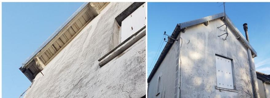
La charpente apparente en rive de pignon est d'allure dégradée (volige), ce qui peut entraîner une dégradation de la couverture et un défaut d'étanchéité à terme. Présence d'un ancien conduit de fumée en fibrociment possiblement amianté (façade arrière)
