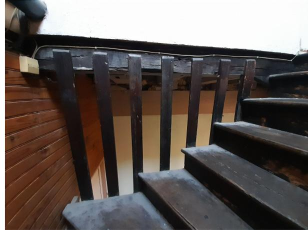
Dispositif anti-chute non-conforme (barreaudage supérieur à 11 cm)
