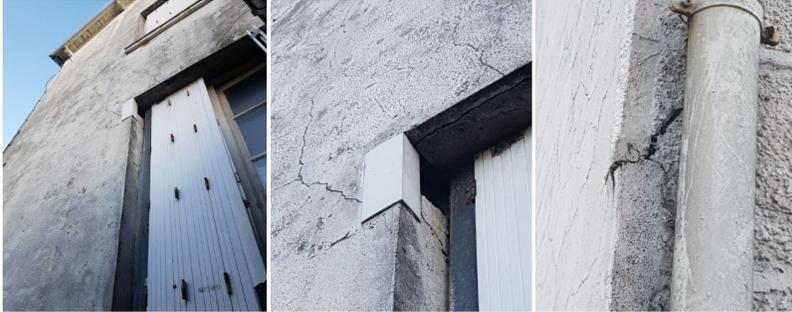
Façades dégradées, fissurations importantes, éclats, réparation douteuse d'un linteau de fenêtre, qui témoignent de désordres structurels mettant potentiellement en cause la stabilité de l'immeuble.
