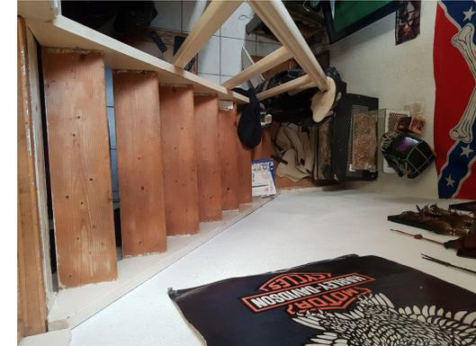
Échelle d'accès à la mezzanine et garde-corps non-conforme et très raide (risque de chute important)
