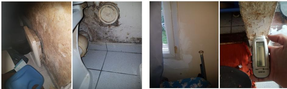
Moisissure très importante dans les murs de salle de bain et dans la cloison du placard de la pièce principale (peinture qui cloque, mur jauni, plâtre dégradé) - prise du taux d'humidité dans le mur (100%)
