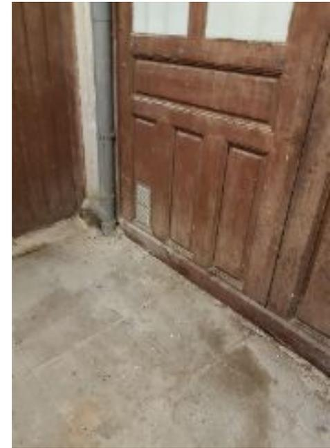
Etat parasite des bois à effectuer + Traitement des infiltrations d'eau + ravalement de la façade sur cour à prévoir + changement des menuiseries + installation système de sécurité incendie
