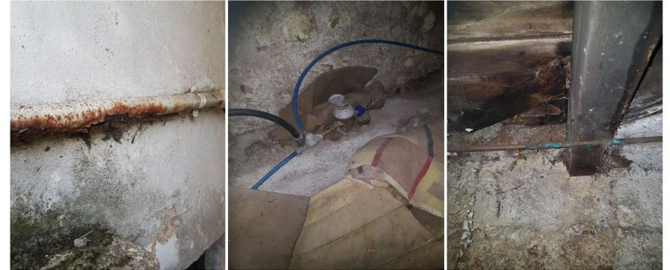
Ancienne canalisation métallique ruinée en façade (EU?), réseau anarchique en sous-sol, raccords douteux, état de dégradation avancé des canalisations.
