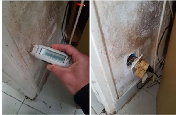
Pièce principale du logement - prise du taux d'humidité dans le mur (100%), couplé à la détérioration de l'appareillage électrique (boîtier sorti de la cloison avec câbles apparents)
