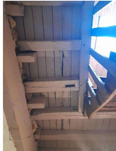
Plancher bois avec traces d'humidité suite aux dégâts des eaux récurrents lorsque l'occupant du dernier étage prend sa douche
