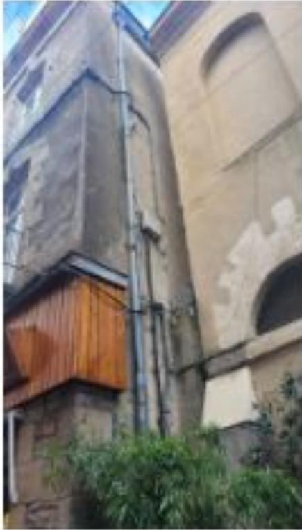
Réseau en façade et un réseau EU dans les EP
