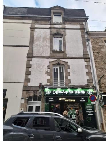
Façade sur Rue de la Fontaine très sale, enduit très dégradé et lézardé, traces noires d'écoulement d'eau autour de la lucarne, garde-corps non-homogènes ou inexistant
