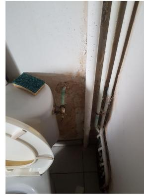
Importantes traces d'humidité à l'arrière des WC (peinture qui cloque et jaunit, plâtre dégradé)
