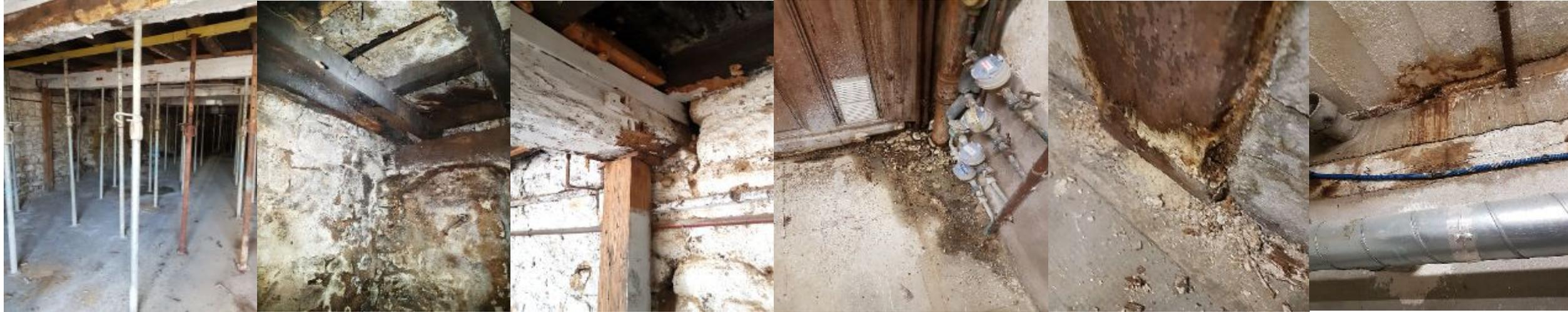
Réfection du plancher haut de garage et travaux induits : remise en état et en conformité du garage, remise en état des parties impactées du logement supérieur Reprise des réseaux d'eaux pluviales et eaux de piscine, protection, drainage et assèchement du Mur Est
