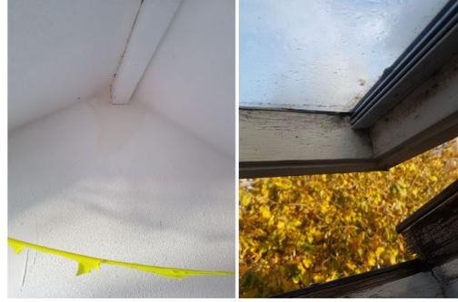
Trace d'humidité en haut du pignon. Fenêtre de toit vétuste (bois noirci et dégradé par l'humidité)
