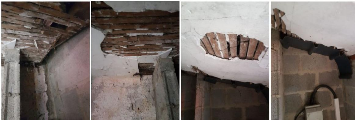
L'appenti (accolé à la maison) faisant office de local technique (arrivées eau et électricité) est très vétuste : plafond plâtre ruiné, morceau de zinc bricolé, présentant un risque de chute d'ouvrage/d'effondrement du plafond
