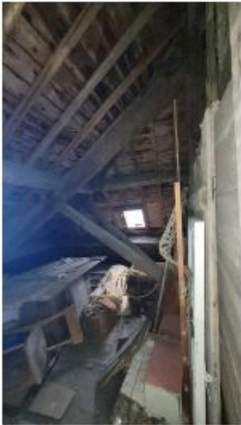
Encombrement grenier et plancher dégradé avec des trous
