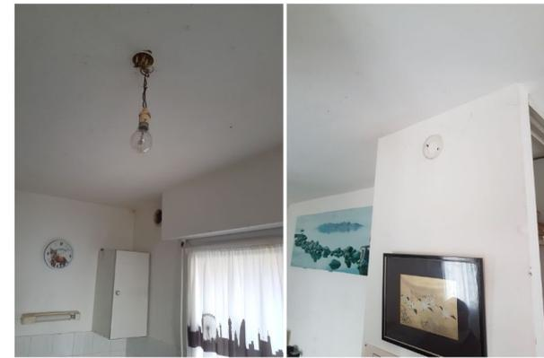
Douille électrique et câbles à nu (pas de boîtier sécurisé). Détecteur incendie manquant
