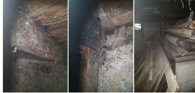
Sous-sol encombré, humide, plancher bois très dégradé d'allure vétuste : insectes xylophages, appuis de solives ruinés, consolidations de fortune, traces d'infiltrations, etc. La structure du plancher est fortement dégradée, mettant en péril immédiat sa stabilité.
