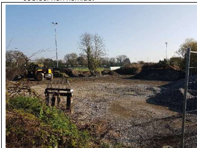
Photo 30 – Zone de transfert de matériaux
