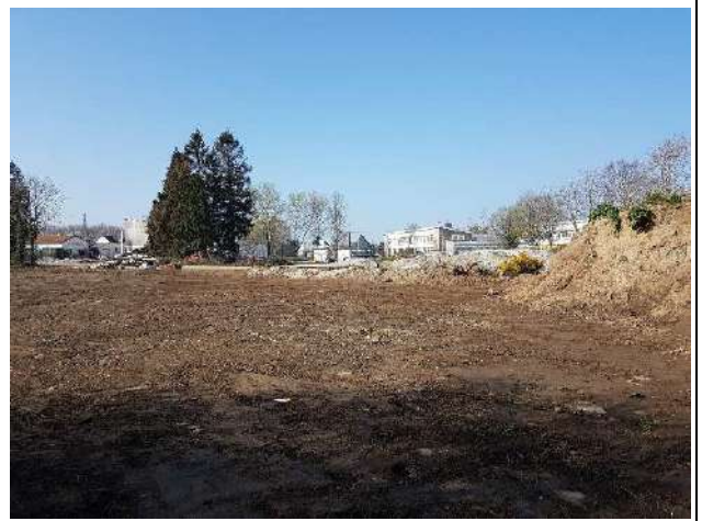
Photo 2 – Espace remblayé récemment
