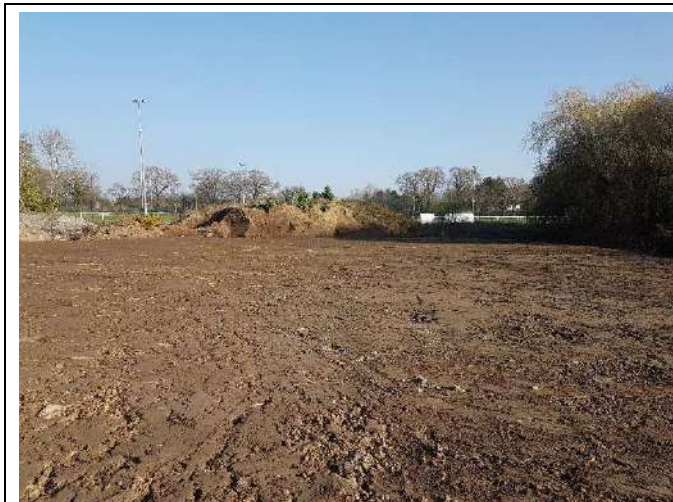
Photo 28 – Remblai de terre végétale
