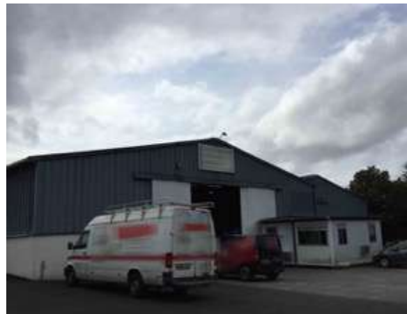
Enseigne parallèle au mur sur panneau de fond – infraction fréquente – dépasse de l'égout du toit - Rue du Général Weygand, Vannes
