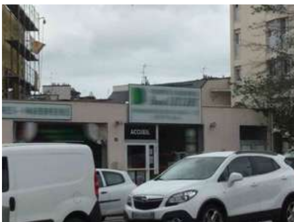
Enseigne parallèle au mur sur panneau de fond en infraction – dépasse du mur – Boulevard de la Paix, Vannes
