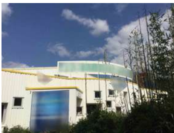
Enseignes sur toitures réalisées avec un panneau de fond – infractions au code de l'environnement – Rue Daniel Gilard, Vannes
