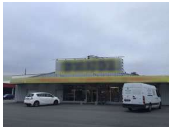
Enseignes sur toitures réalisées avec un panneau de fond éclairé par projection – infractions au code de l'environnement – Rue Alain Gerbault, Vannes
