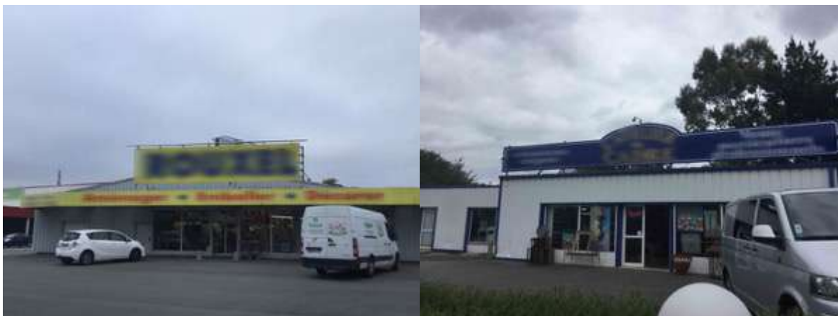
Enseigne sur toiture ou terrasse en tenant lieu réalisée sans lettres découpées – Rue Alain Gerbault, Vannes
