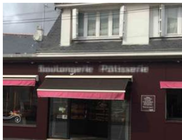
Enseigne parallèle au mur réalisée en lettre découpée – Avenue de Verdun, Vannes
