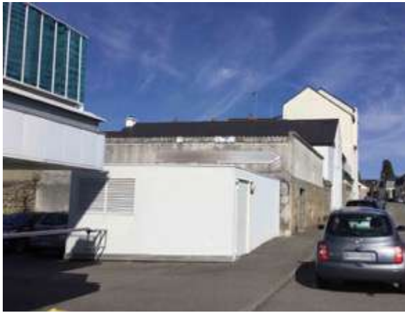
Préenseigne en forme de flèche apposée sous l'égout du toit, Rue des 4 Frères Creach, Vannes
