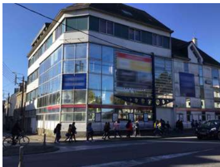
Enseigne temporaire parallèle au mur – Place de la libération, Vannes
