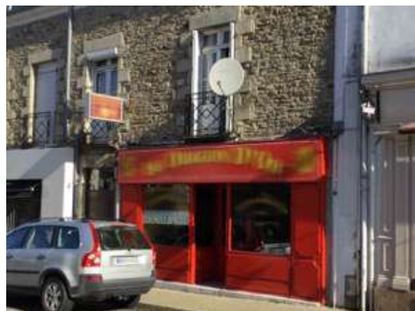
Non-alignement des enseignes – Rue Maréchal Leclerc, Vannes
