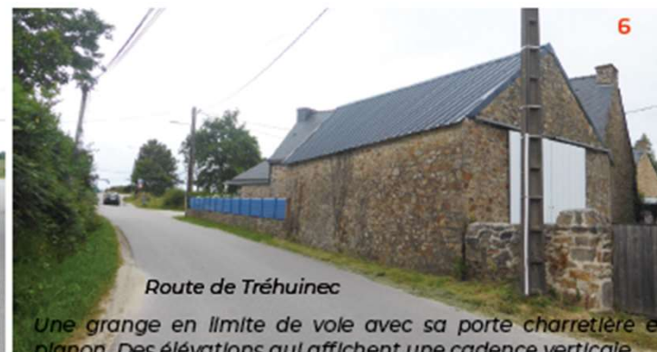
Murets en pierre seches très dégradés
