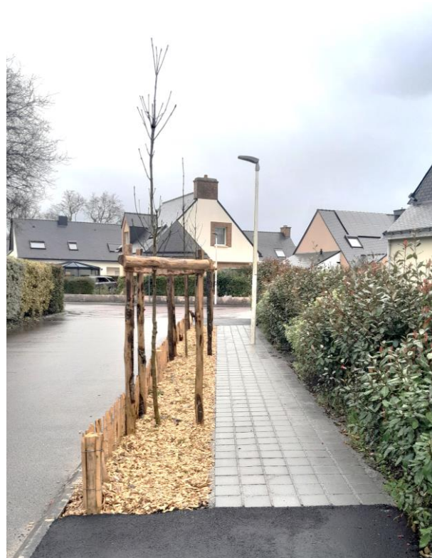
Après (fosse de plantation alimentée par les eaux de ruissellement)
