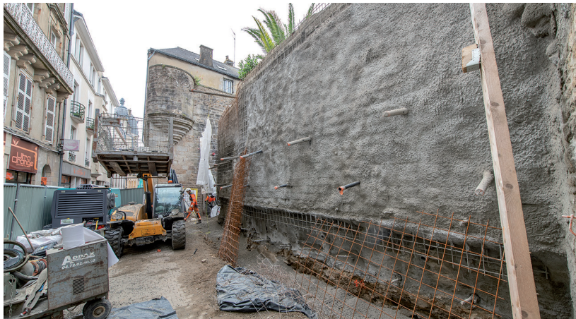
Le mur a été sécurisé avec une structure béton. L'habillage de pierres démarrera en septembre pour une livraison fin octobre.
