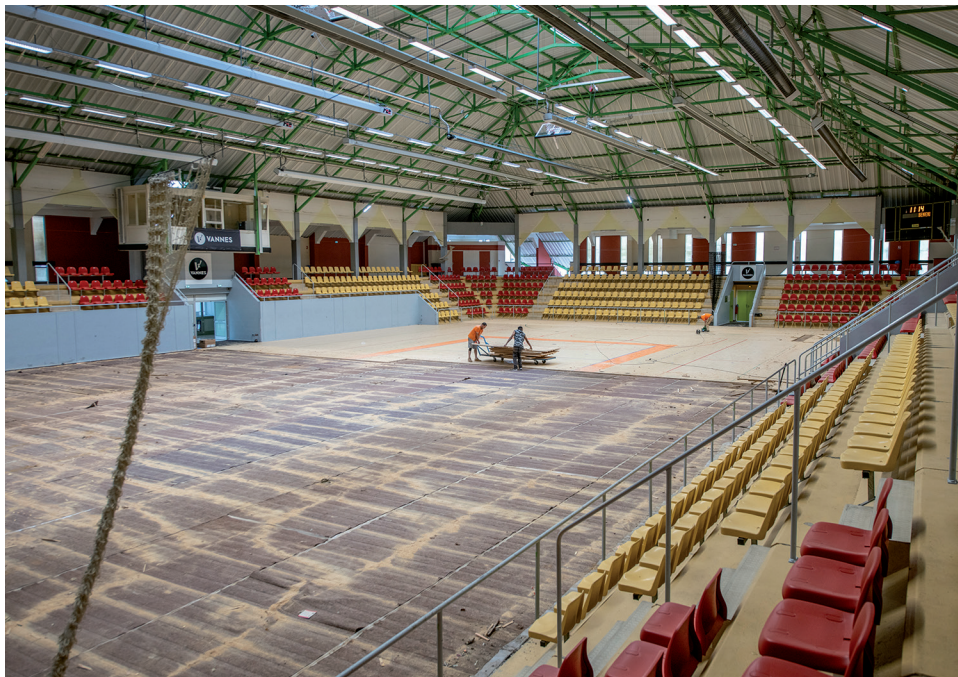
La durée de vie d'un revêtement sportif de type parquet, est en moyenne de 25 ans. Celui de la salle omnisports de Kercado avait besoin d'être renouvelé. © Eléonore Bohn
