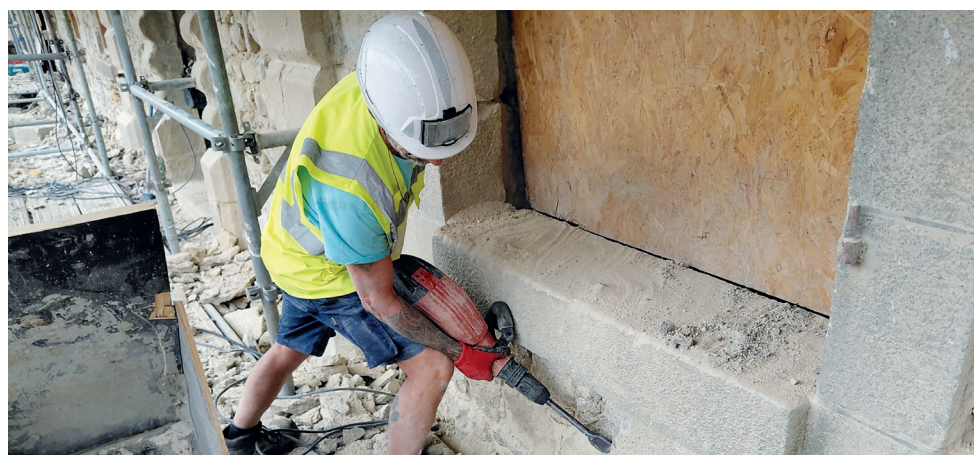
Un ouvrier en action pendant la phase de purge des pierres.
